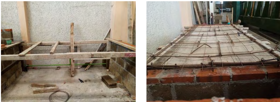
Figura 3-12 Cimbrado y armado de la losa que simula la calle
