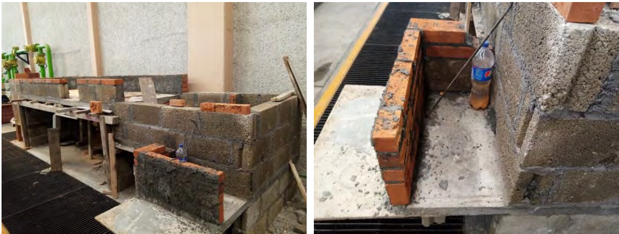
Figura 3-14 Construcción de muros del modelo físico
