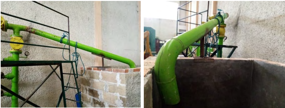
Figura 3-17 Instalación de la tubería de alimentación de agua para el modelo físico
