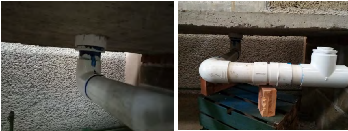
Figura 3-18 Instalación de tubería y cople para captación del caudal.
