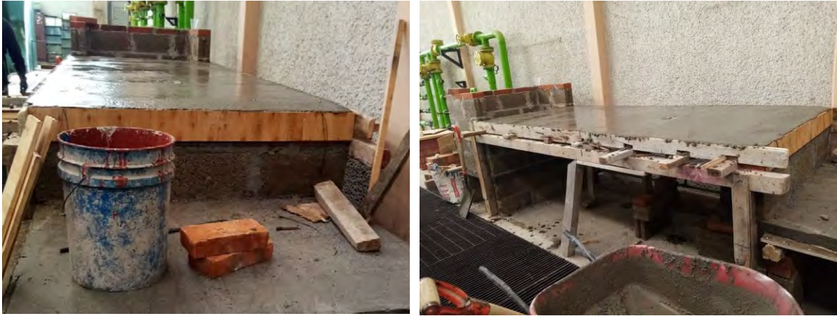
Figura 3-13 Colado de la losa del modelo físico
