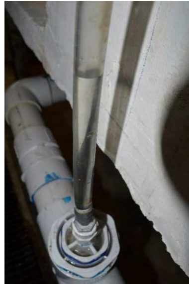
Figura 3-20 Piezómetro instalado en el modelo físico.
