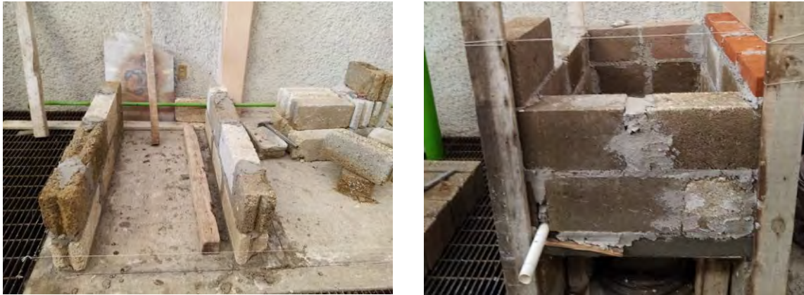
Figura 3-11 Construcción del tanque de entrada del agua
