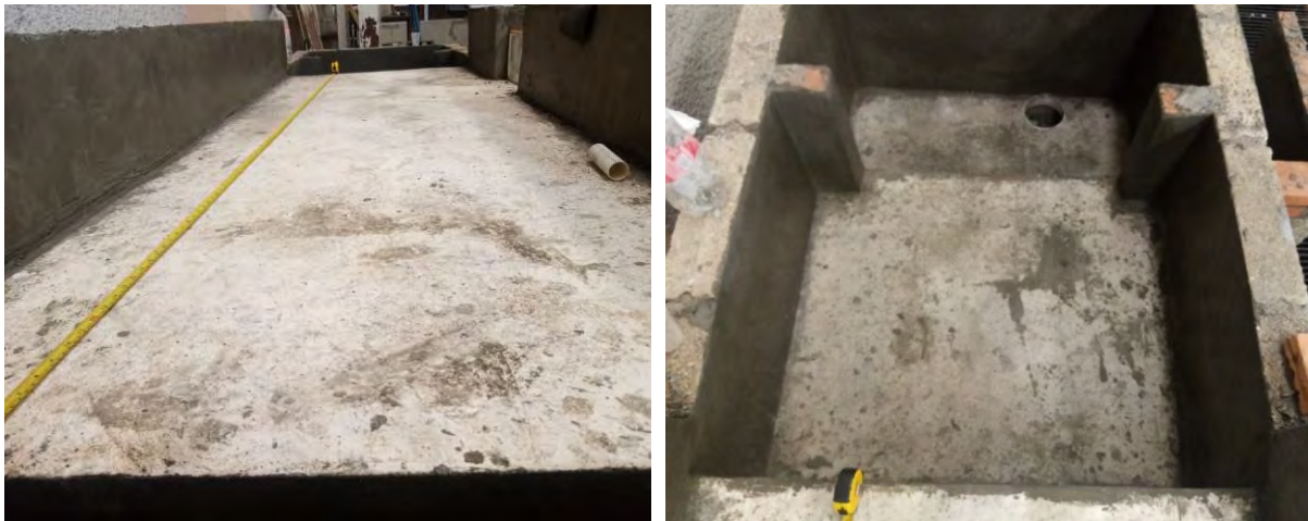
Figura 3-16 Pulido de muros y tanques del modelo físico.
